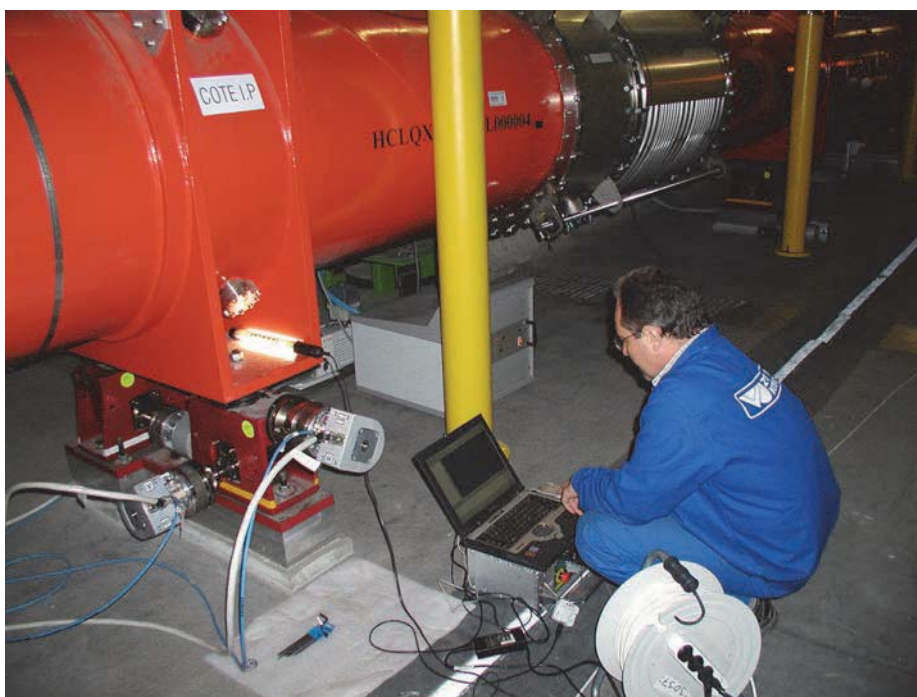
Oživovanie systému pohonov na polohovanie tripletu kryomagnetov v CERN-e
